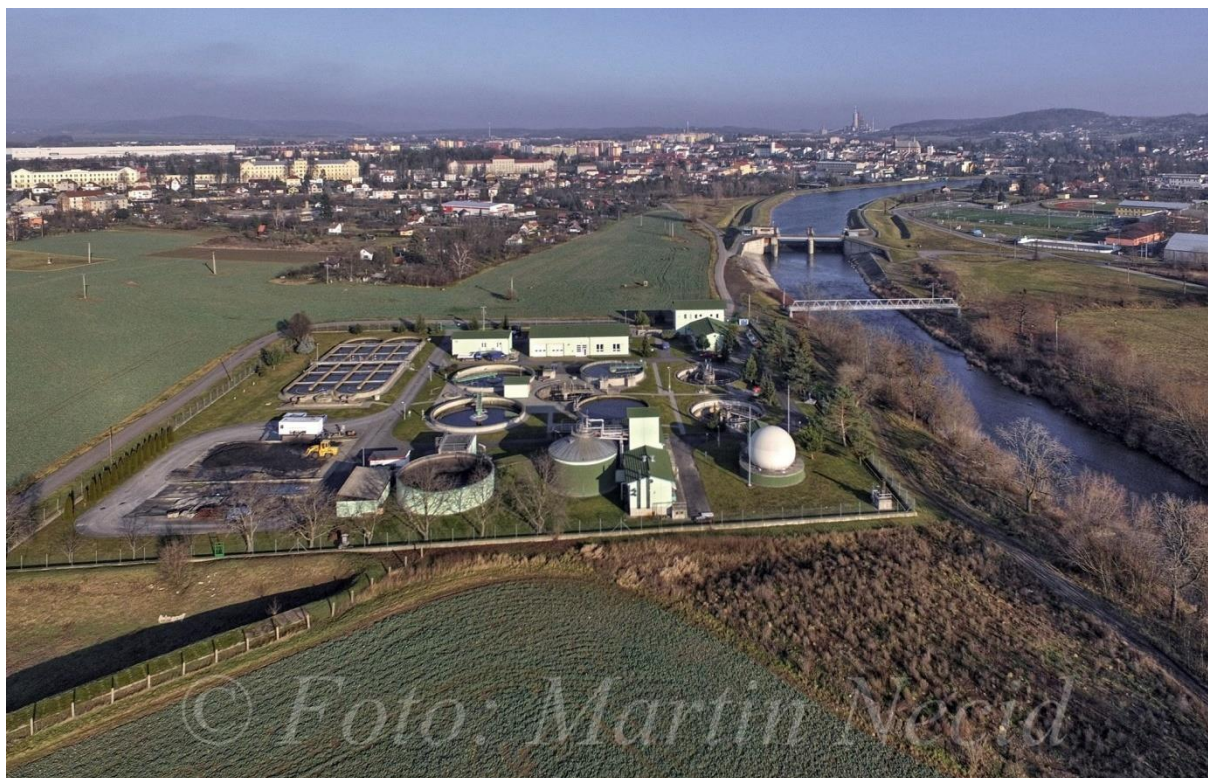
Obr. 41 Letecký pohled na komplex čistírny odpadních vod v Hranicích (zdroj: Martin Neced)
