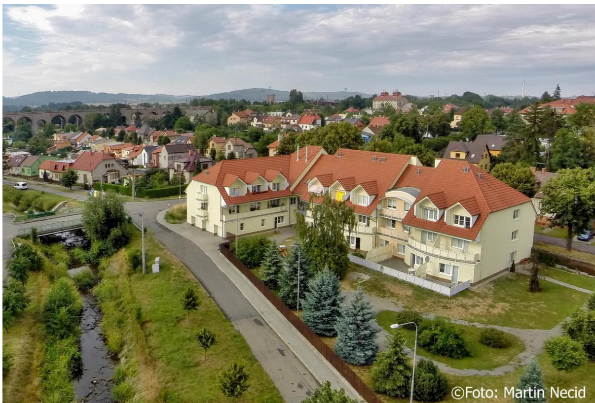
Obr. 28 Domov seniorů na ul. Tovačovského v Hranicích (zdroj: Martin Necid)
